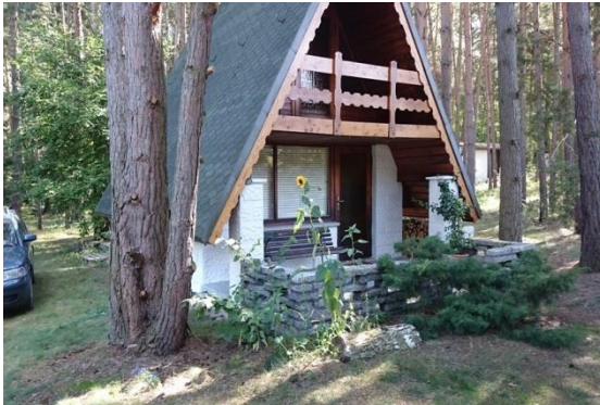
Foto 1: Eingang zur Finnhütte
